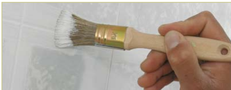
Har fliserne tilbageliggende fuger, så husk at male fugen først.
