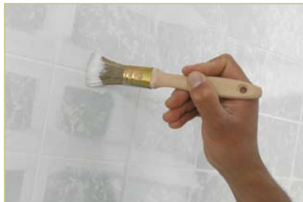
Grundning af fuger med pensel.
